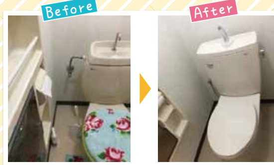
Aマンション1階 トイレより水漏れ お客様の要望で 一式交換
